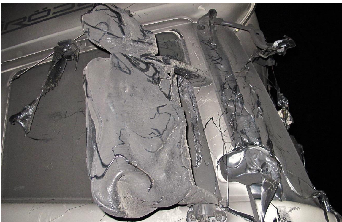
Figur 25: Varme-, smelte- og røykskader på trekkbilen til vogntoget lokalisert 123 meter bak det brennende vogntoget i tunnellopet. Foto: SHT
