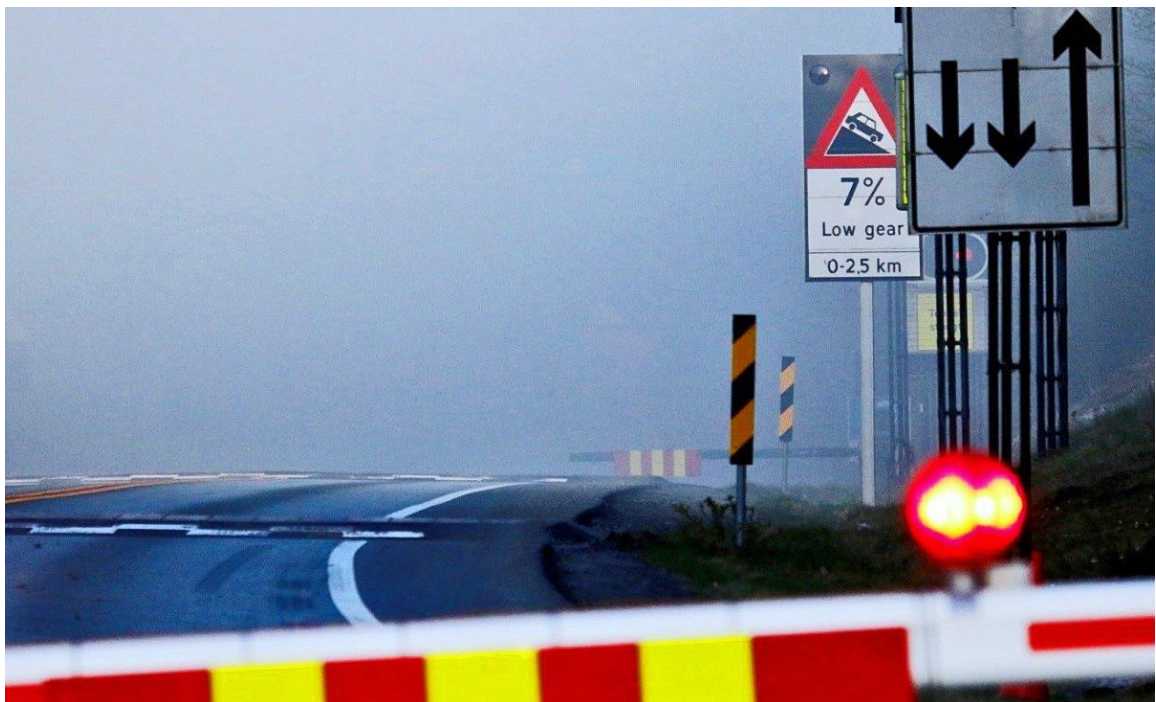
Figur 35: Nedsenkbar bom med varsellys og skilting utenfor Oslofjordtunnelen. Røykutvikling fra tunnelen i forbindelse med kjøretøybrannen kan også sees i bildet. Foto: Joakim Fjeldli/DRM 24
