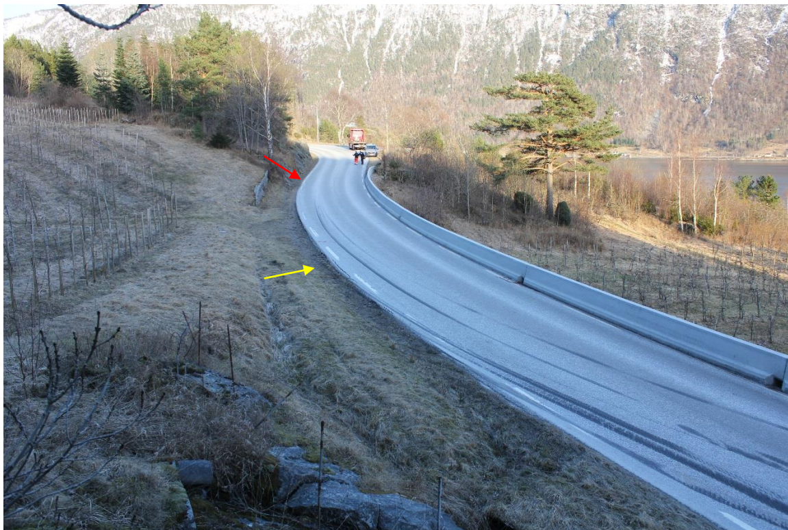
Figur 9: Området der det høgre hjulet på tankbilen var utanfor vegen og spor etter tankbilen i vegbana. Foto/illustrasjon: Statens vegvesen/SHT
