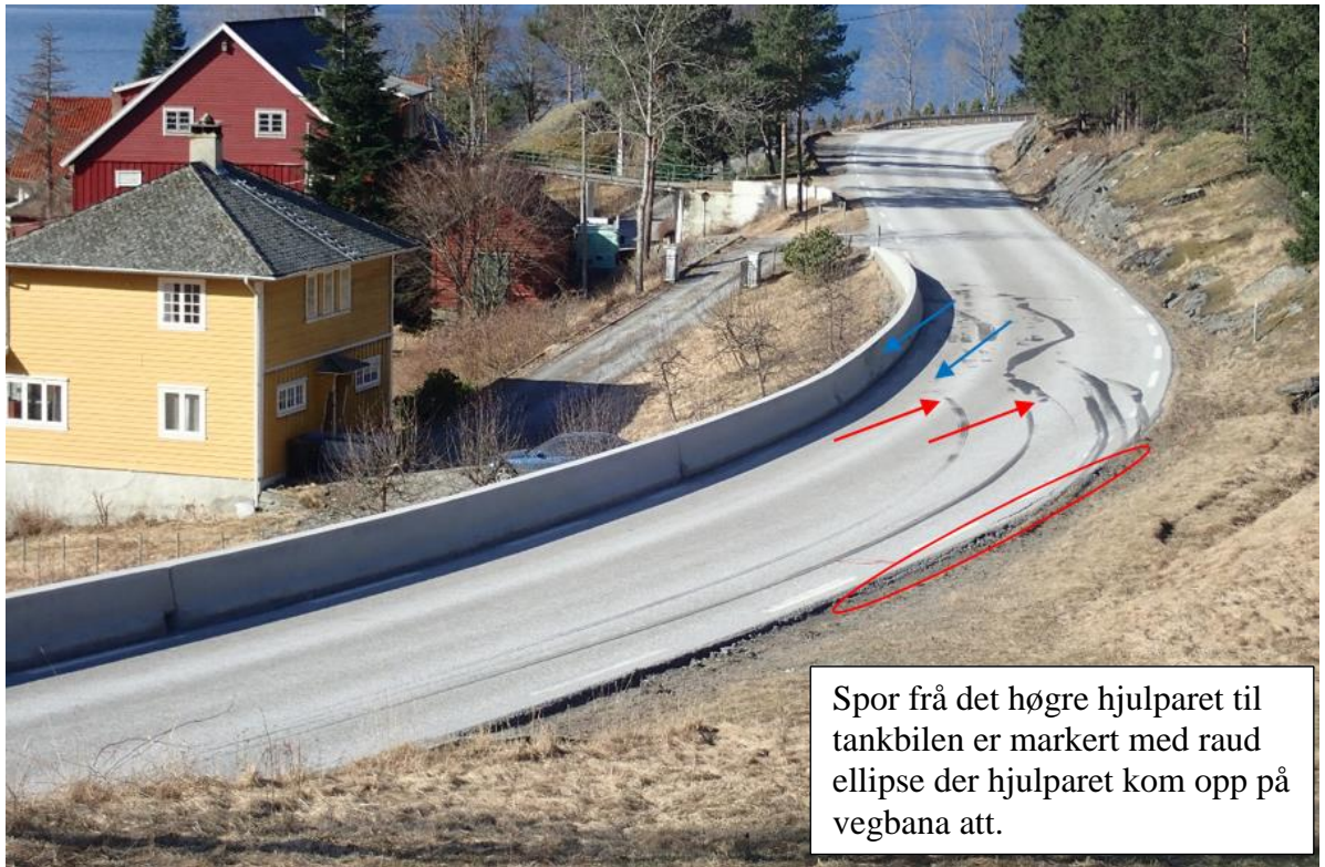
Figur 10: Biletet viser kurva og spora som blei avsette der ulukka hende, sett i køyreretninga til tankbilen. Dei røde pilene viser spor etter tankbilen. Dei blå pilene viser sporavsetjing/merke etter personbilen. Foto/illustrasjon: SHT
