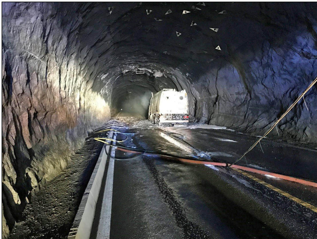
Figur 7: Sluttposisjonen til feiebilen inne i tunnelen, sett i retning mot Skei. Foto: Politiet
