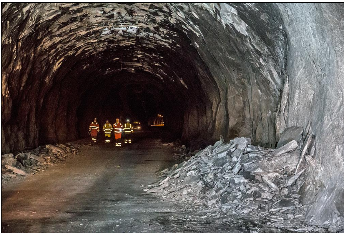
Figur 6: Skadar i tunnelen som følgje av køyretøybrannen. Foto: Silje Drevdal/Statens vegvesen
