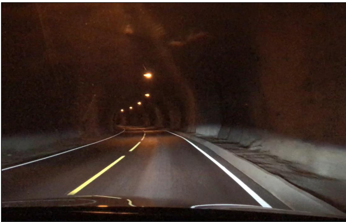
Figur 9: Tverrsnittet av tunnelen sett i køyreretninga mot Fjærland. Kabelgata følgjer høgre sida av køyrebanen og er avgrensa med kantstein. Foto: SHT
