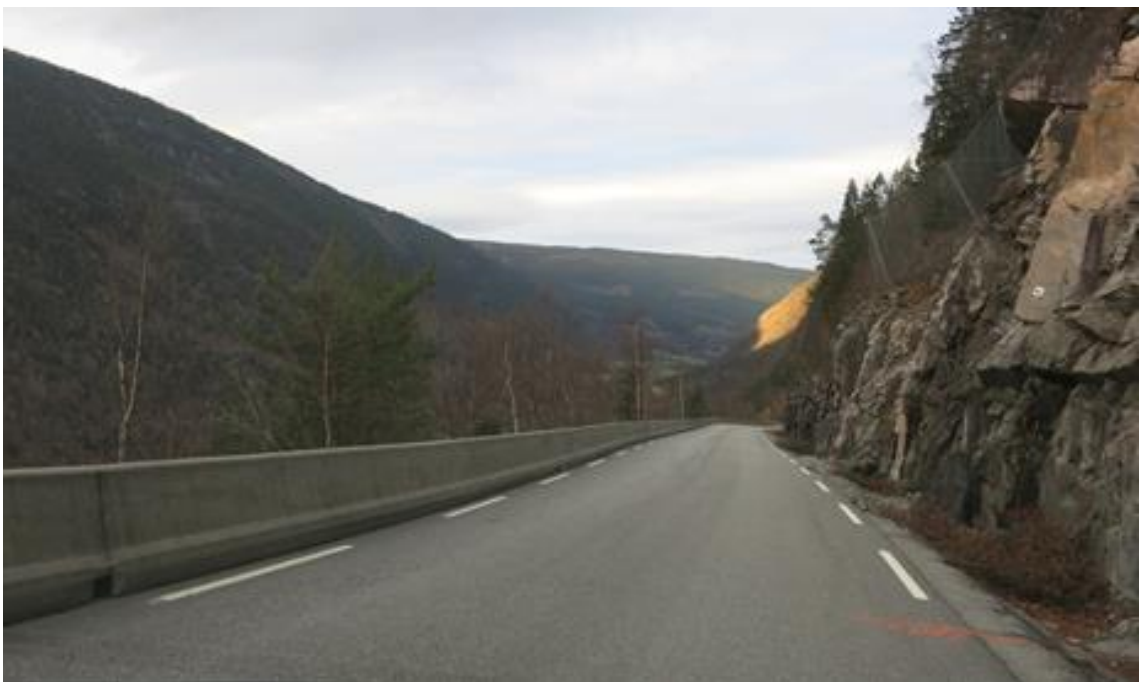
Figur 27: Vegmiljø 400 meter fra ulykkesstedet. Foto: SHT
