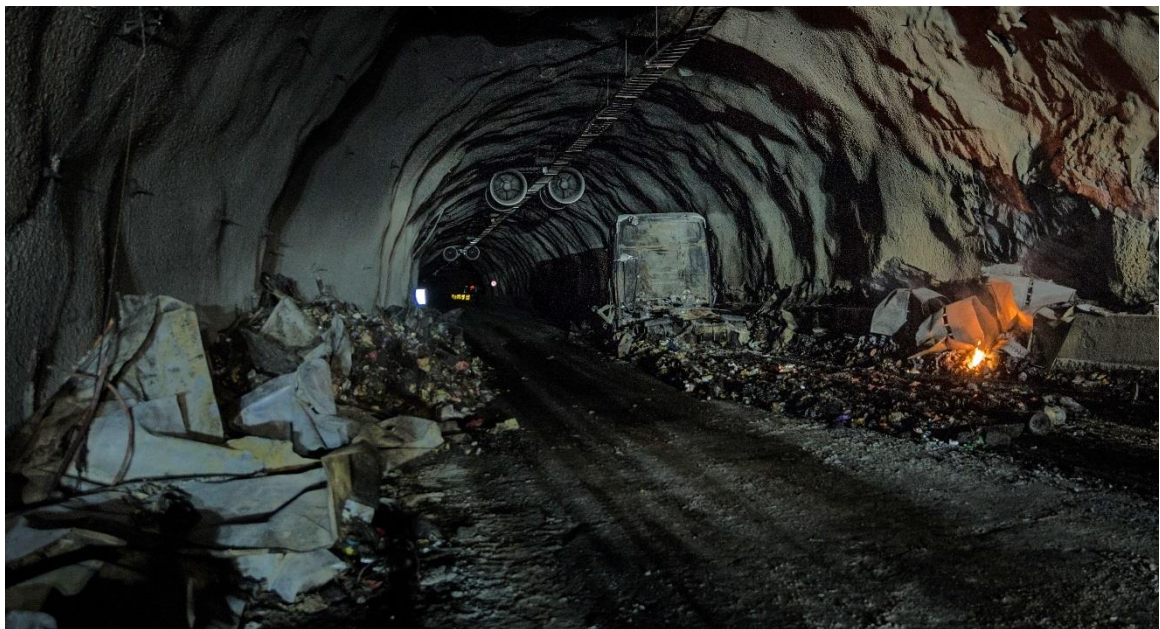
Figur 15: Lasta blei fordelt ut til sidene under etterslukkingsarbeidet. Biletet blei teke etter at semitilhengaren var frakta ut søndag 31. mars kl. 1600. Foto: Statens vegvesen
