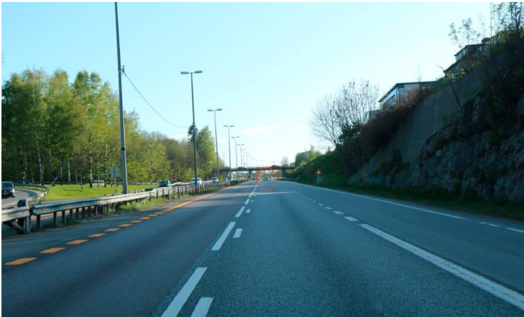
Figur 21: Bildet er tatt ca. 250 meter før ulykkesstedet kl. 1846 dagen etter ulykken. Den røde ringen viser politibilen som er plassert ved sluttposisjonen til vogntoget. Foto: Politiet
