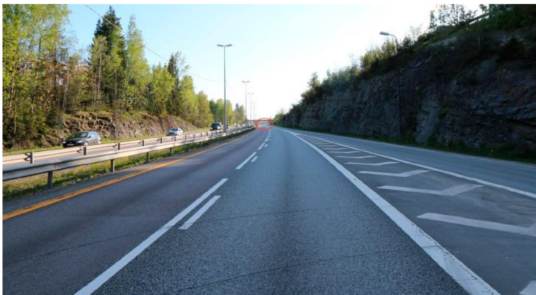
Figur 20: Bildet er tatt ca. 400 meter før ulykkesstedet kl. 1846 dagen etter ulykken. Den røde ringen viser politibilen som er plassert ved sluttposisjonen til vogntoget. Foto: Politiet
