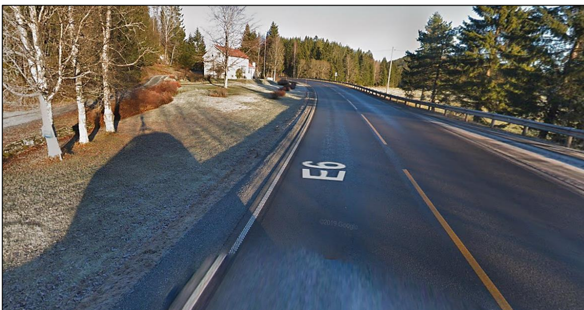
Figur 3: Veistrekningen hvor vogntogene kolliderte, sett i nordgående kjøreretning. Foto: Google Maps
