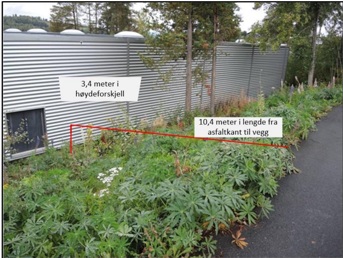
Figur 3: Avstanden fra næringsbygget til asfaltkanten til kjøregården hvor eleven kjørte utfor. Foto: SHK
