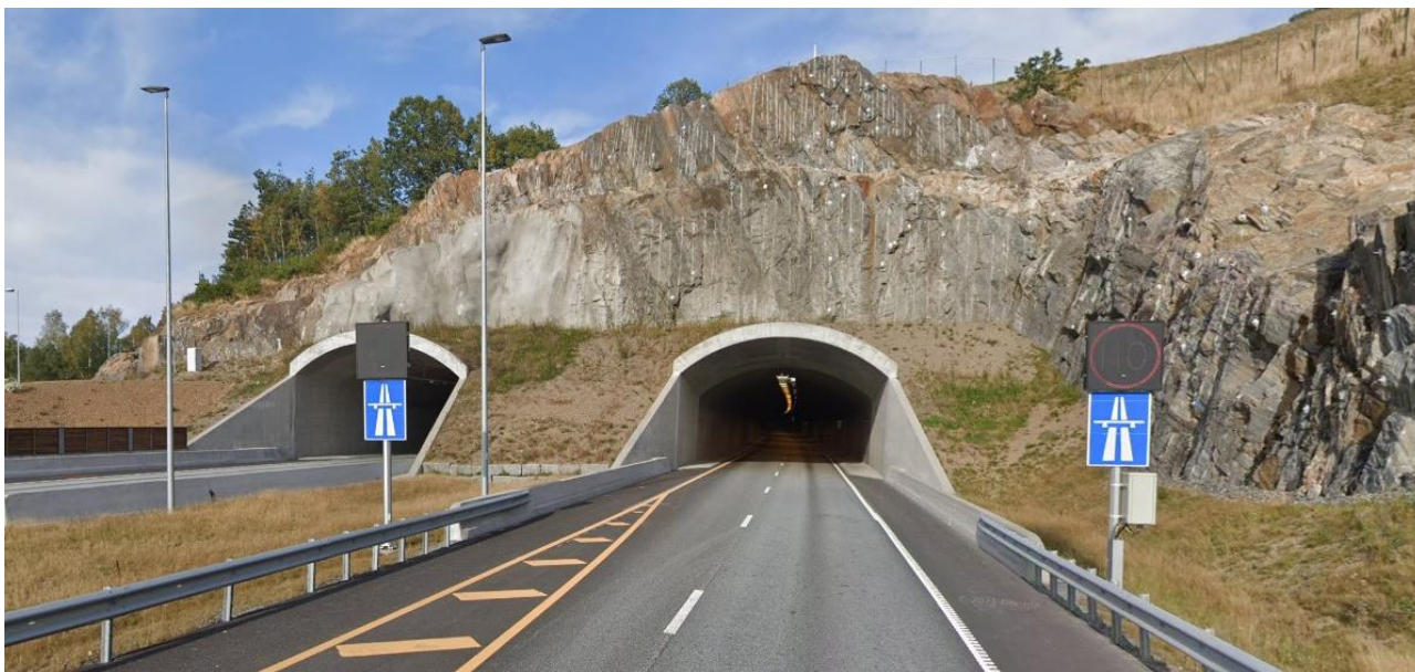
Figur 19: Portalen til Torsbuåstunnelen med elektroniske fartsgrenseskilt, sett i nordgående kjøreretning. Foto: Google Maps
