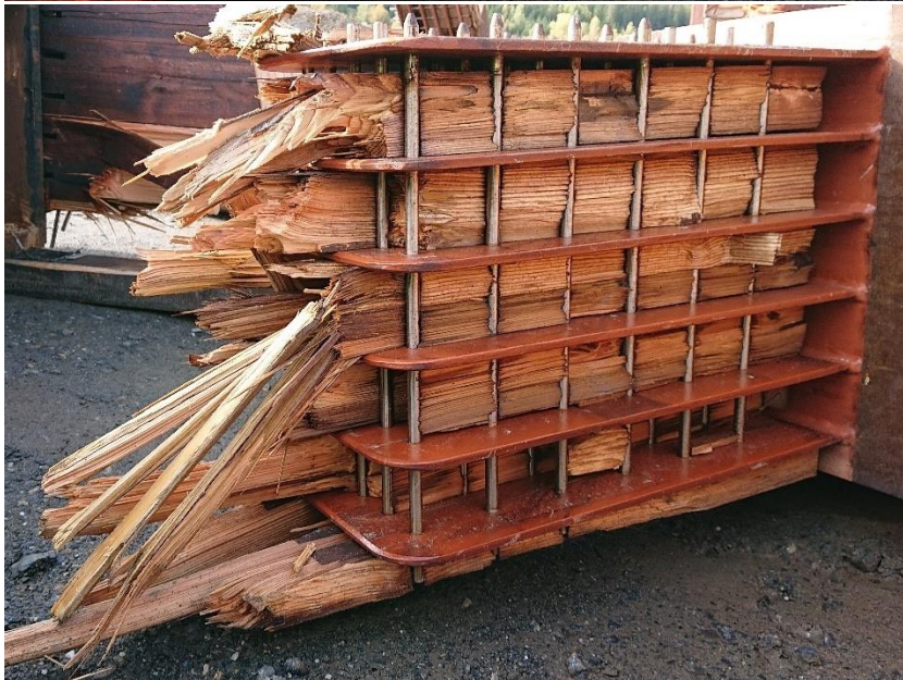
Figur 143 Knutepunkt OG16B, innfesting av diagonal 7B, etter berging.
