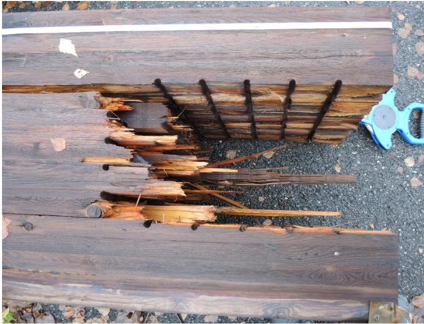
Figur 136 Innfesting av diagonal 6B, trolig mot knutepunkt OG14B
