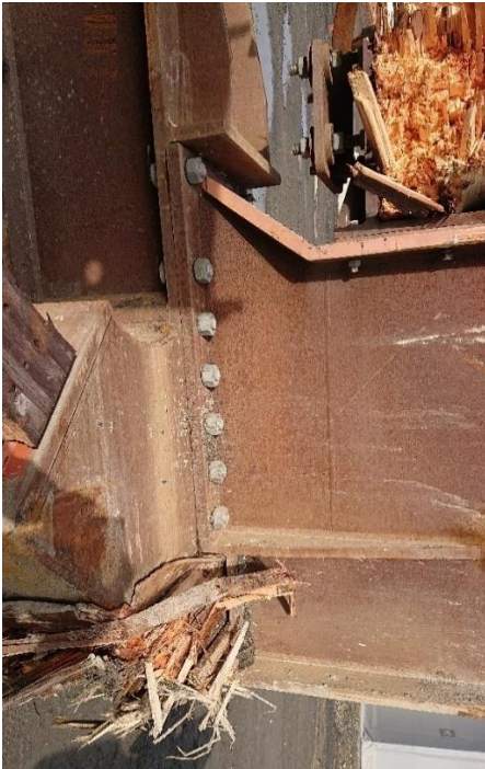
Figur 85 Prinsipp for feste mellom tverrbærer og stålvertikal (bildet er fra akse 2)
