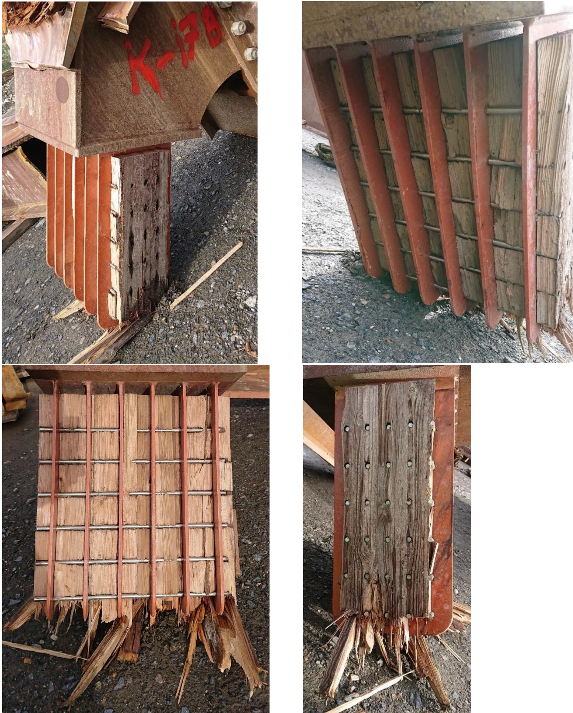
Figur 144 Innfesting av diagonal 7B ved knutepunkt UG17B
