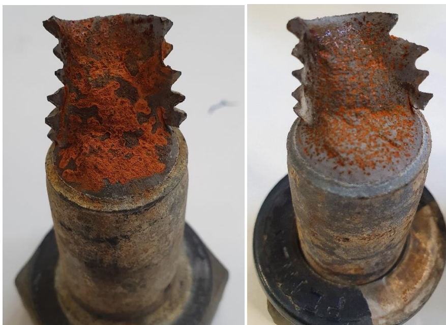
Figur 161. Korrodert bruddflate på Bolt B-2.4 og B-2.2
