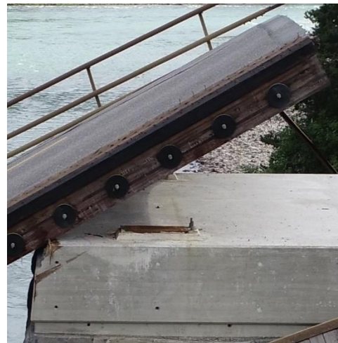
Figur 74 Feste av tverrbærer mot betongfundamentet i akse 1, de to M20 boltene er slitt av. Såleplaten med M30 er intakt.
