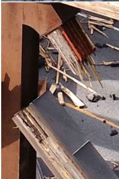
Figur 142 Knutepunkt OG16B og diagonal 7B, dronebilder fra brustedet
