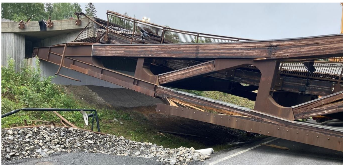
Figur 98 Opplager ved akse 4, oppstrøms side.
