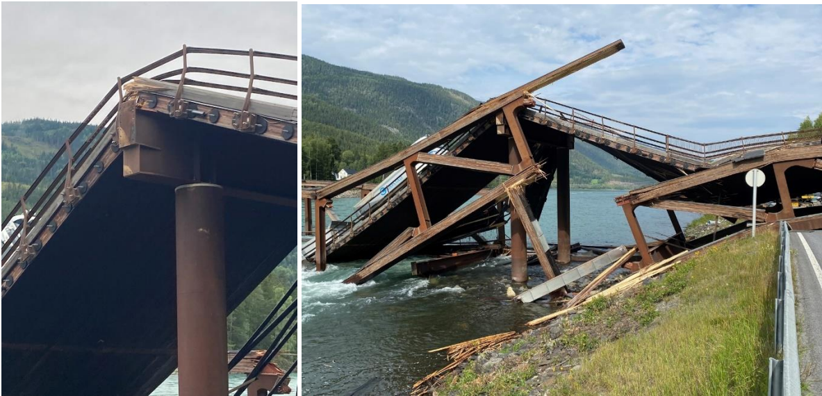
Figur 90 Tverrbærere i knutepunkt 31, oppstrøms til venstre og nedstrøms til høyre.
