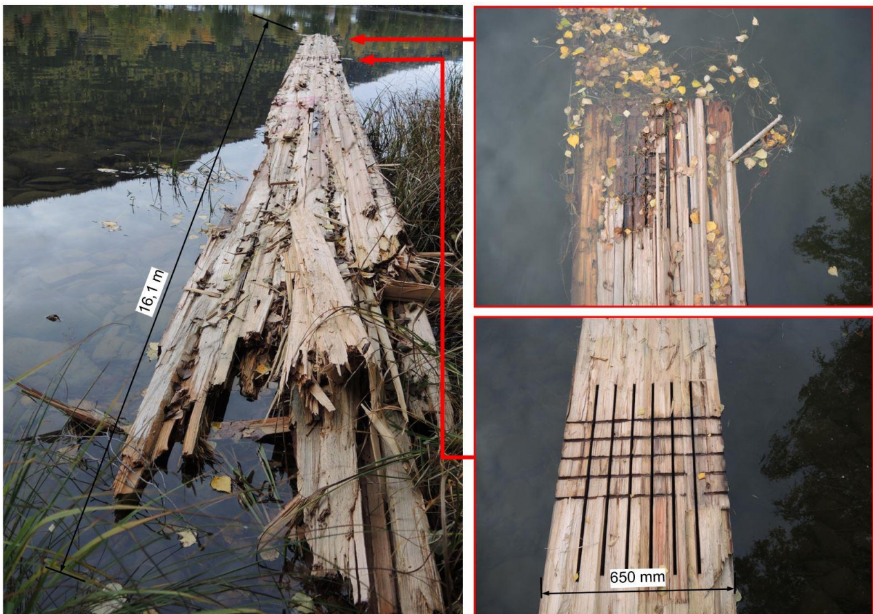
Figur 12 Avskallet del av undergurt mellomknutepunkt 9 og 15 funnet langt nedstrøms (foto: Statens Havarikommisjon)
