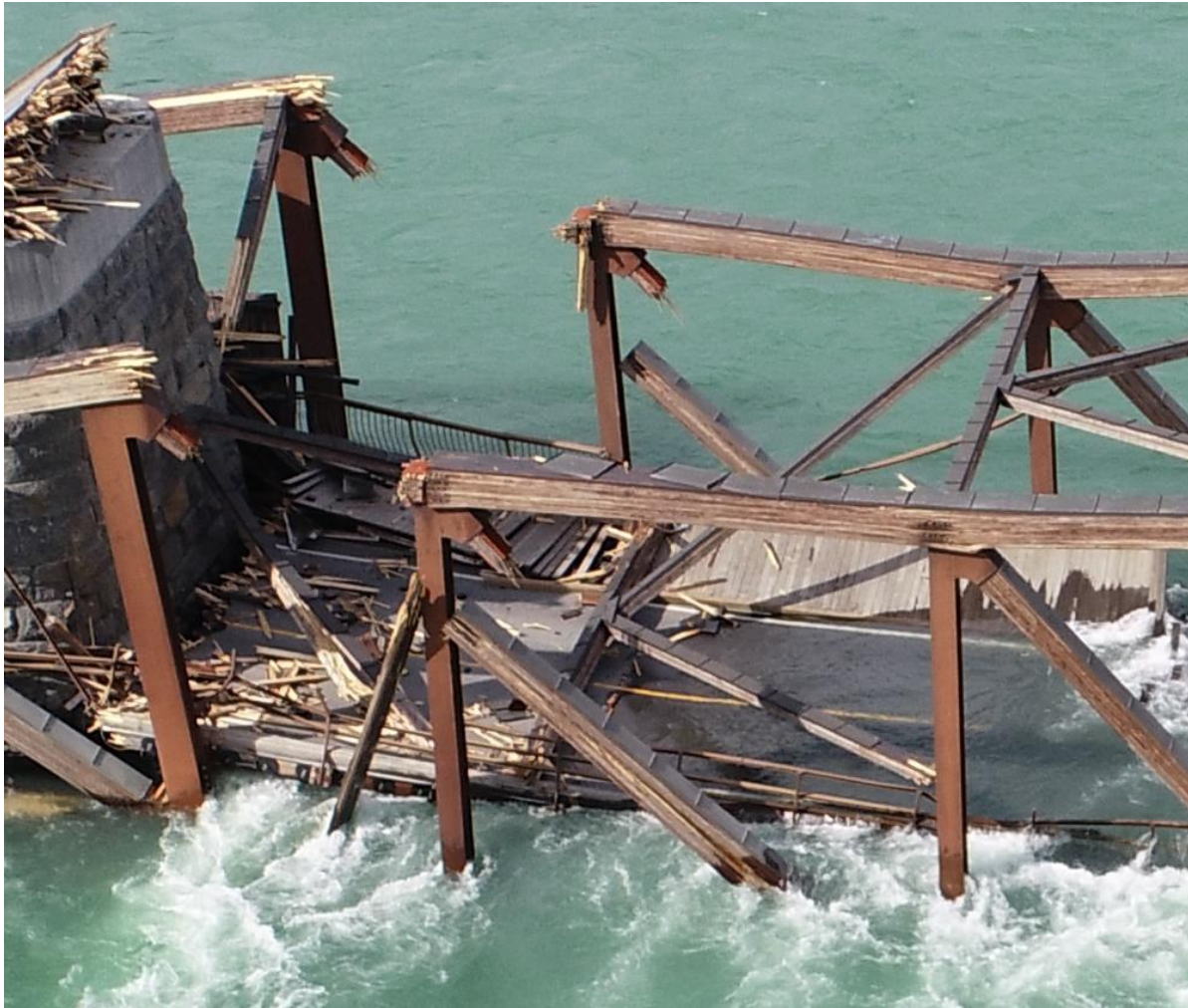
Figur 128 Bilder tatt med drone ca. 8 timer etter brukollapsen (kilde: Statens havarikommisjon).
