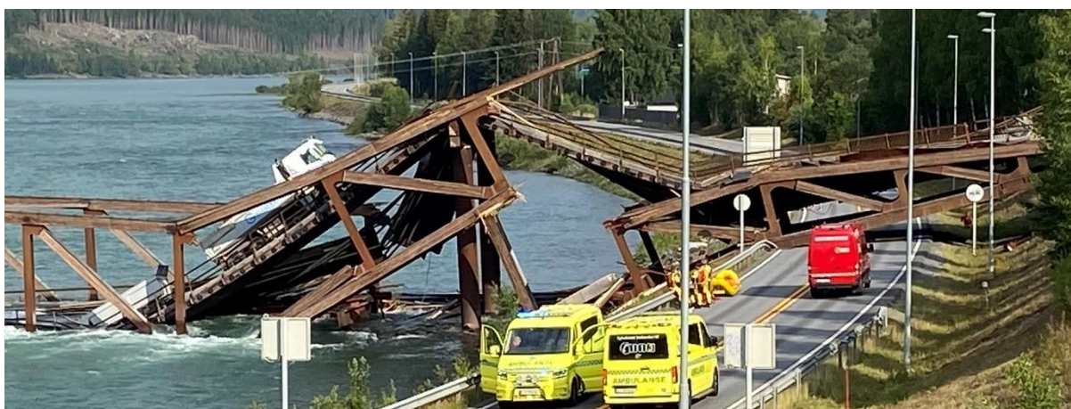
Figur 96 Foto fra situasjonen ved akse 3 rett etter kollapsen
