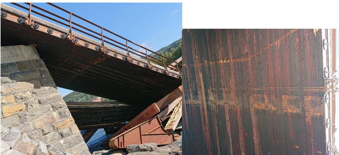
Figur 76 Avtrykket av veltet tverrbærer på undersiden av tredekket ved akse 1. Til høyre nærbilde av avtrykket av tverrbæreren på nedstrøms side.
