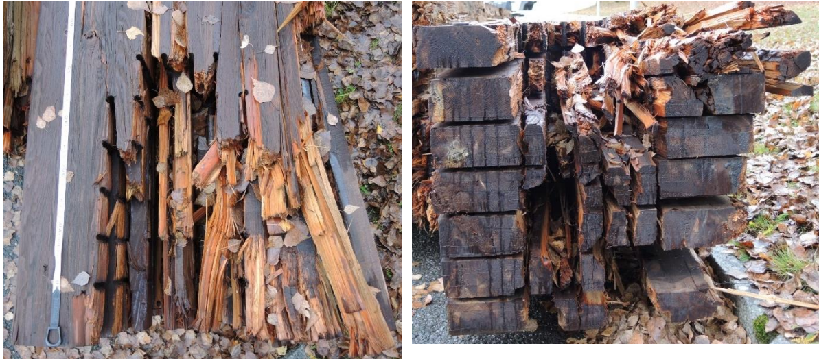
Figur 138 Innfesting av diagonal 6B, trolig mot knutepunkt UG15B
