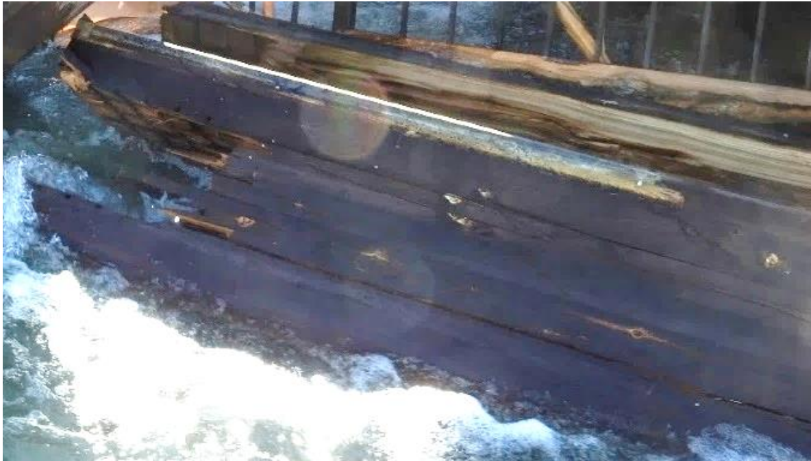
Figur 131 Diagonal 6A, innfesting trolig mot OG14A
