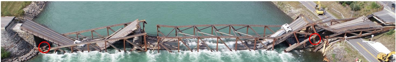
Figur 17: Tretten bru 15. august 2022, kl. 1515. Foto: SHK
