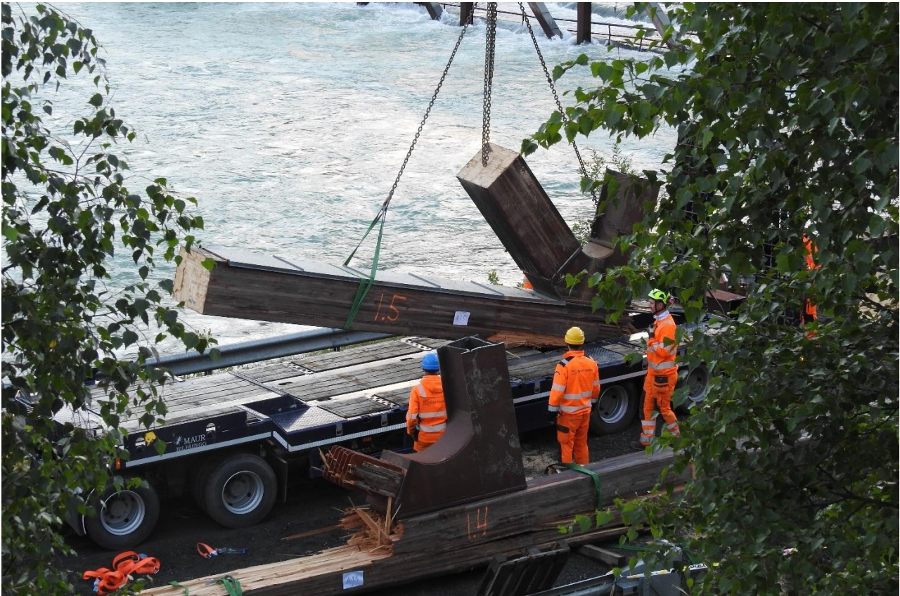
Figur 8: Transport av deler fra brua. Foto: SHK
