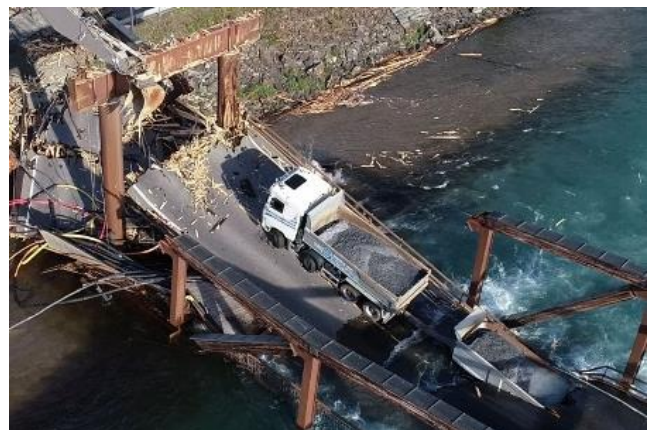
Figur 10: Senking ned langs brupilarene. Foto: SHK
