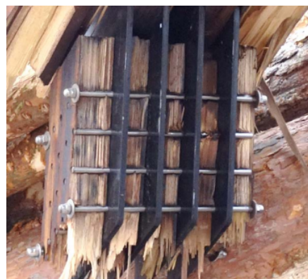
Bilde av blokkutrivning fra Perkolo bru
