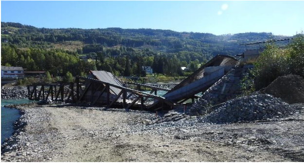
Figur 4: Anleggsvei på vestsiden av brua, bildet tatt 7. september 2022. Foto: Havarikommisjonen
