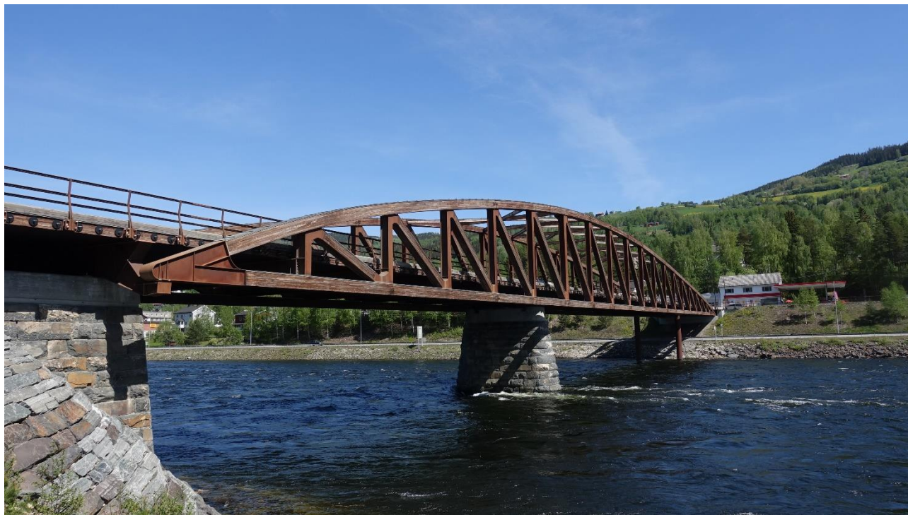
Figur 3: Tretten bru (2021). Kilde: Brutus, Statens vegvesen
