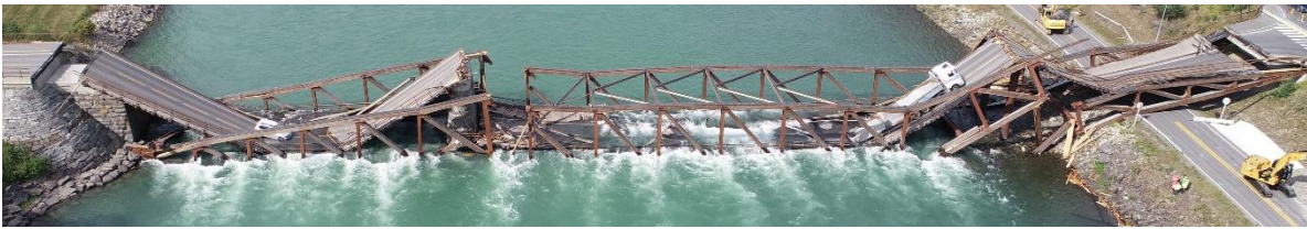
Figur 11: Tretten bru 15. august 2022, kl. 1515. Foto: SHK
