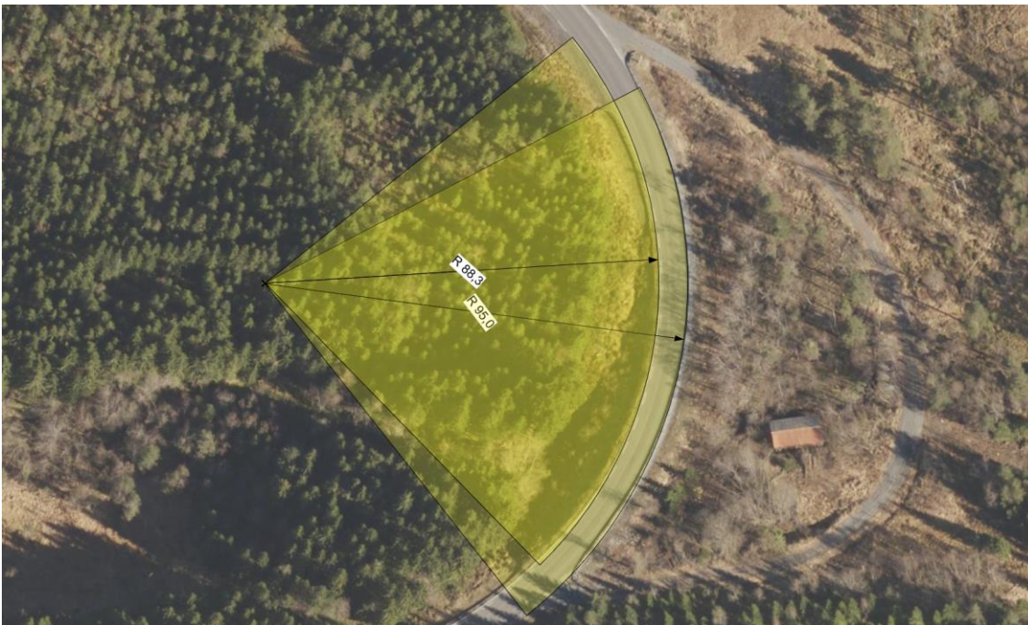
Figur 25: Indre og ytre kurveradius målt fra flyfoto. Flyfoto: 12.05.2017 Geovekst. Måling: SHK
