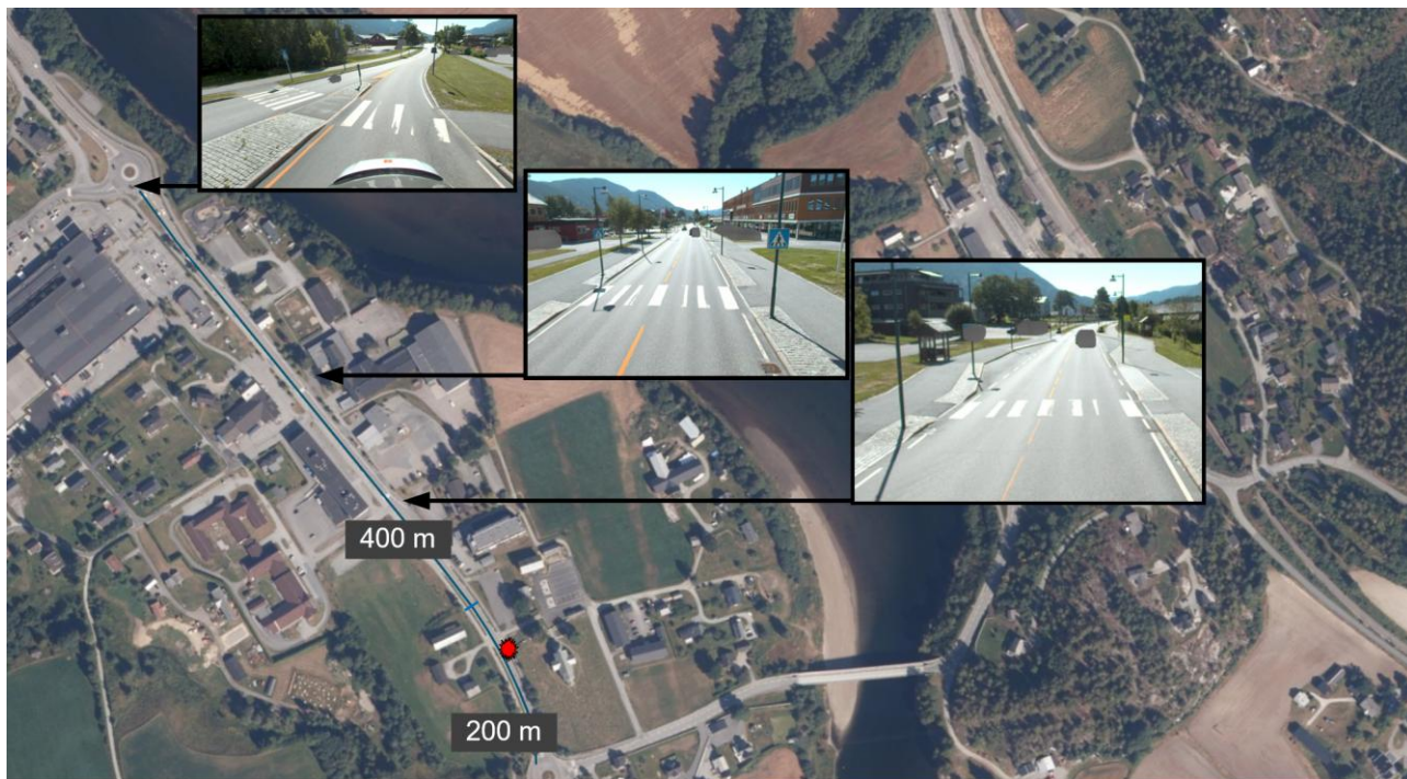
Figur 20: Sentrumsvegen med gangfelt, slik det var utformet på ulykkestidspunktet. Kilde: Statens vegvesen , vegbilder tatt 25. juni 2024.
