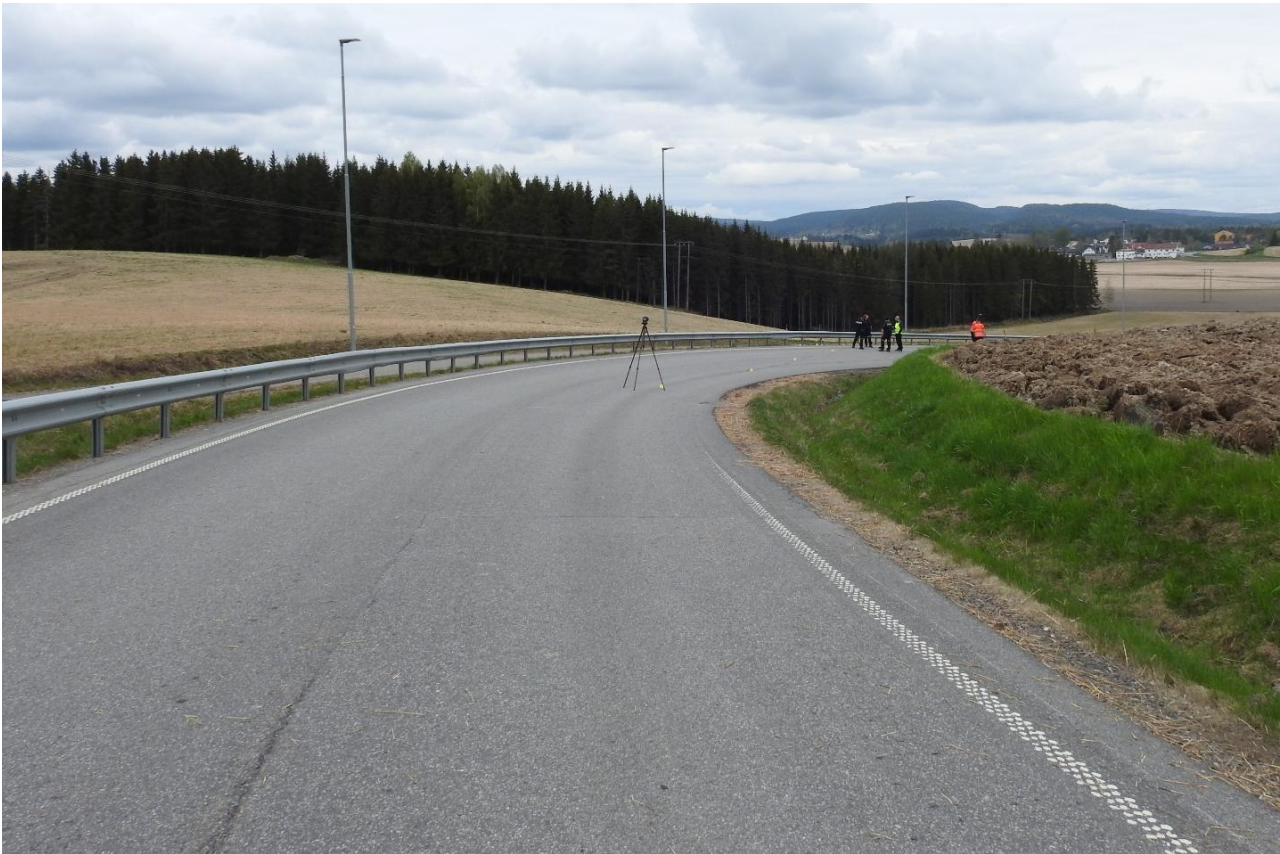
Figur 32: Rekkverk i ytterkant av høyrekurven på fv. 115 ved ulykkesstedet, sett i motorsykkelens kjøreretning. Rekkverket er et stålskinnerekkverk med stålstooper. Stolpeavstanden er 2 m. Foto: SHK
