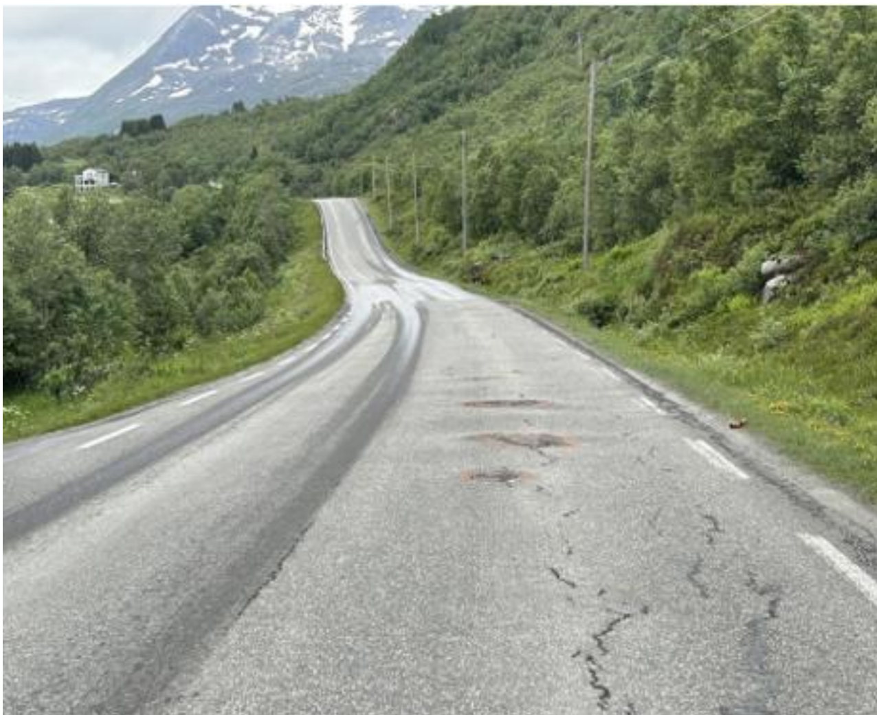
Figur 3: Ulykkesstedet sett i motorsyklistens kjøreretning. Oransje markering i veibanen er påført av politiet etter ulykken. Foto: Politiet
