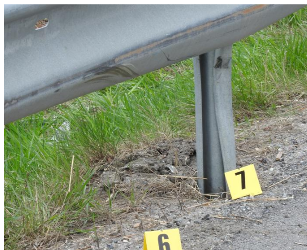
Figur 4: Motorsyklisten på fv. 115 i Aurskog-Høland traff en rekkverksstolpe og omkom av skadene. Foto: SHK
