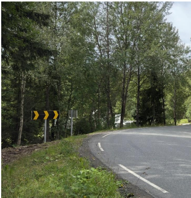
Figur 9: Ny bakgrunnsmarkering i høyrekurven langs fv. 115 i Indre Østfold. Foto: SHK
