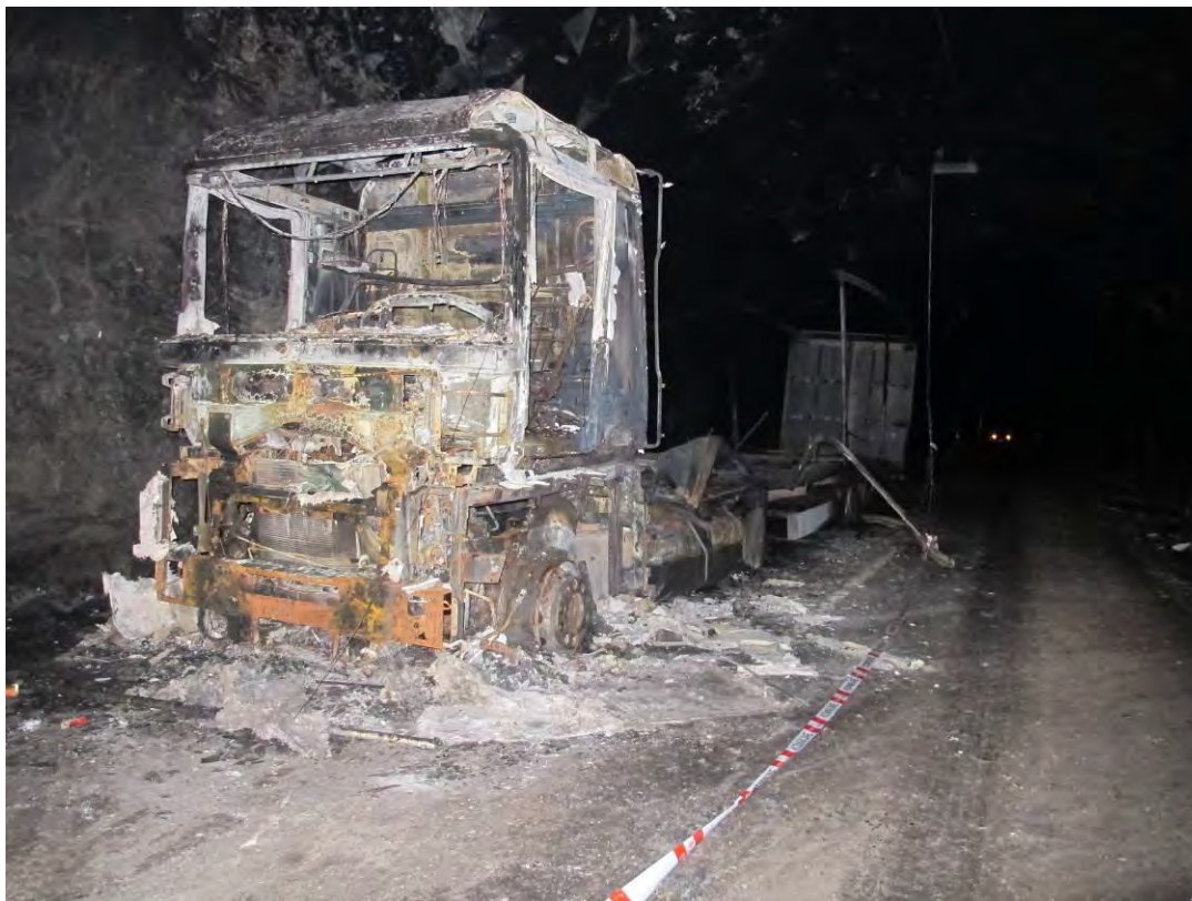
Figur 3: Vogntoget slik det ble stående etter brannen i Gudvangtunnelen. Foto: SHT
