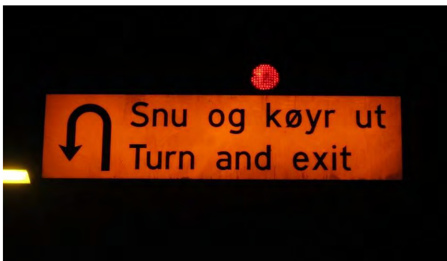
Figur 17: Skilt som kan vises ved stenging av tunnelen. Foto: SHT
