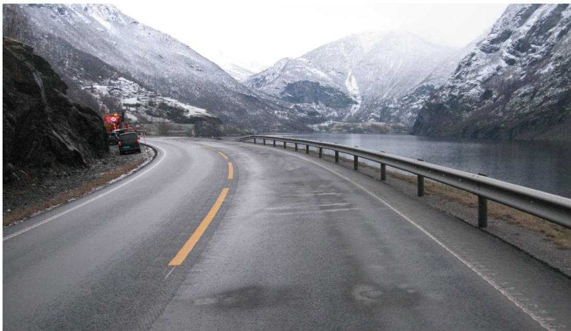
Figur 11: Ulykkesstedet. Sentralt i bildet vises skadene på rekkverket på høyre side av veien etter velten. Bildet er tatt ca. kl. 1200 samme dag som ulykken skjedde. Foto: Politiet
