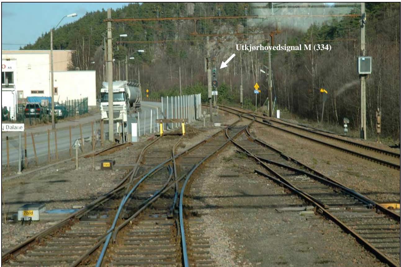
Figur 06: Sett fra toget i kjøretning mot felles utkjørhovedsignal M (334). Riksvei 9 sees til venstre for sporene. Bildet viser at endebutten etter reparasjonen har blitt dreiet noe mot høyre for å unngå å komme i konflikt med riksvei 9.
