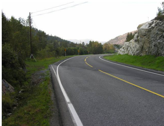
Figur 13: Overgang mellom ny og gammel vei sett i motsatt kjøreretning.
