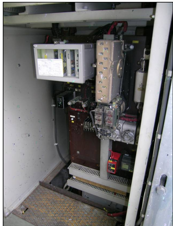
Figur 8: Utstyr med vern i likeretterstasjonen på Slemdal.
