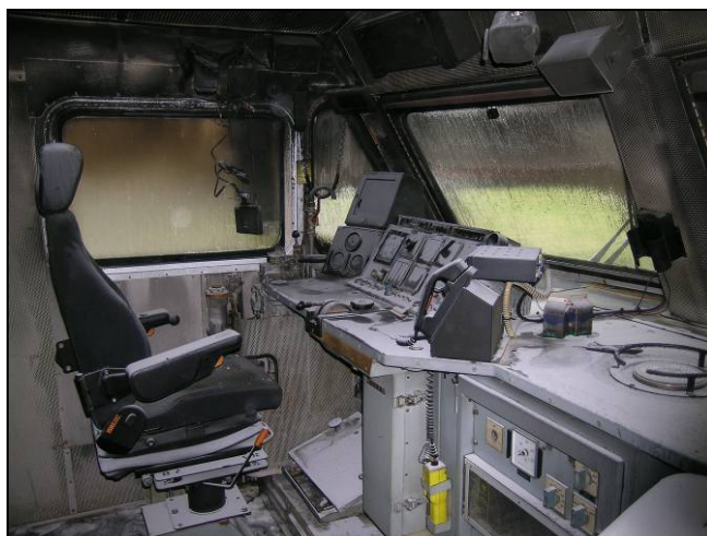
Figur 3 Brannskader i det ene førerrommet til lokomotiv 16.2216.
