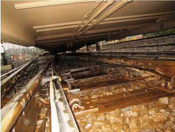
Figur 3: Brudd i sporvekseltunge under toget.
