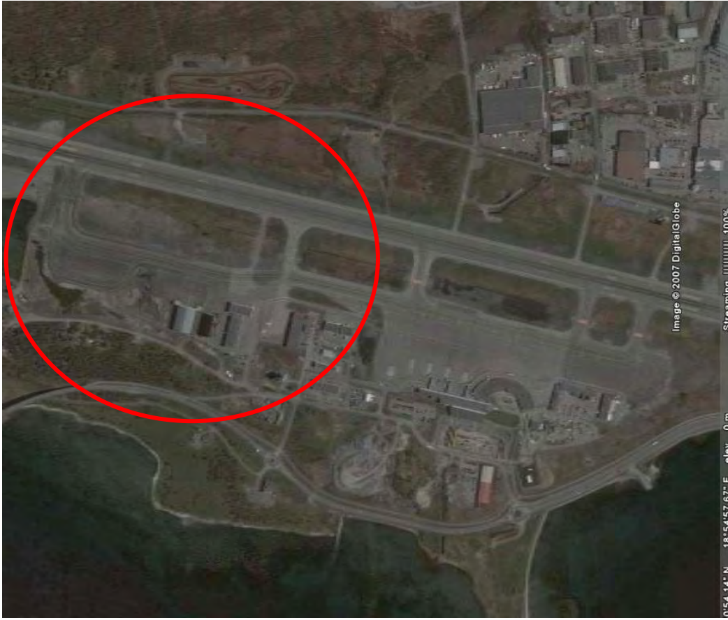
Figur 3: Bilde fra Google Earth, lastet ned 23.11.2007. Viser forlengelsen av TWY Y, samt den nyetablerte TWY E lengst nord i bildet. Bildet er gjengitt med tillatelse fra Google ©.
