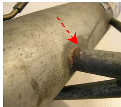
Sprekk ved innfesting av stag
