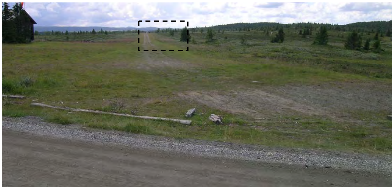
Fig. 4 a Bilde tatt fra veien foran terskelen bane 15. Utsnitt: Se fig. 4 b
