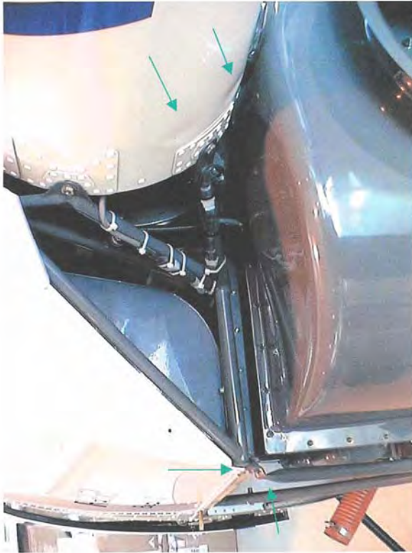
Bilde 1 viser skadeområder ved rammens øvre venstre innfesting og halekonens innfesting
