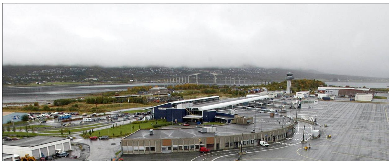
Figur 4. Utsnitt av bilde tatt i retning nordvest under "Åpen dag" en time før hendelsen. (Foto: Yngve Olsen Sæbbe/Avinor Tromsø lufthavn)
