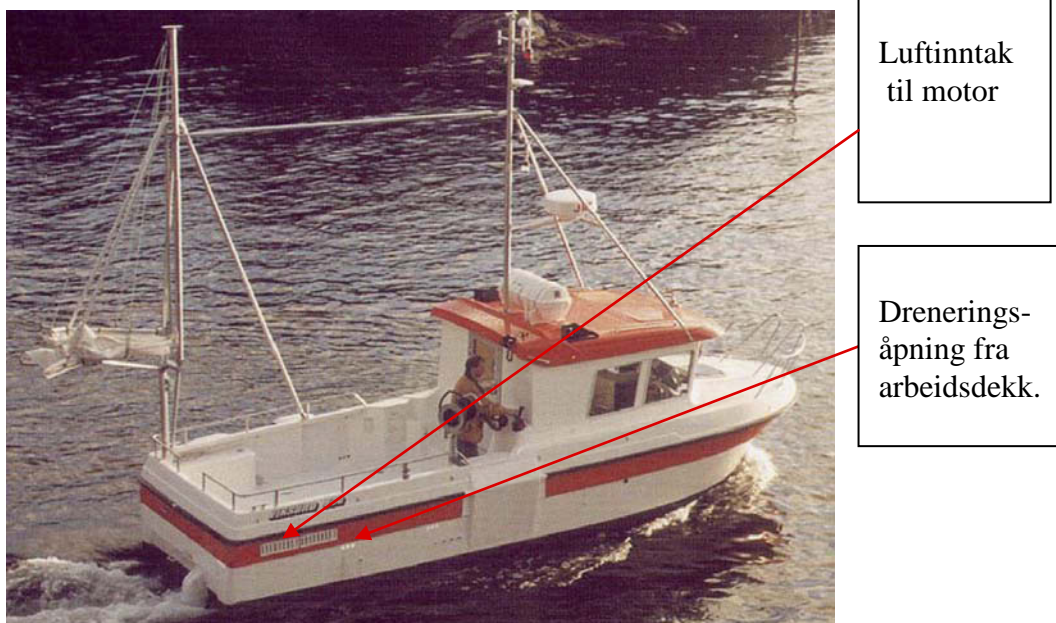
Figur 11: Luftinntak til motor på Viksund 900. Åpningen har høyde over dekk på 290 mm. I henhold til NBS skal ventilasjonsåpninger være minst 450 mm over dekk. Foto: Viksund
