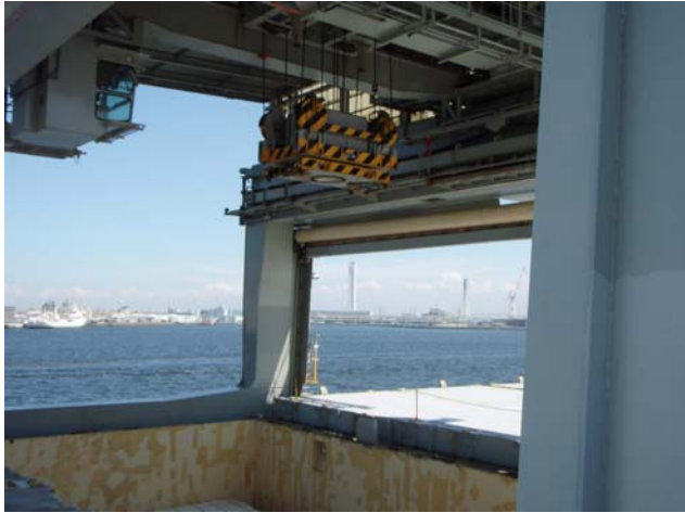
Figur 7: Utsikt fra manøverplattform.
