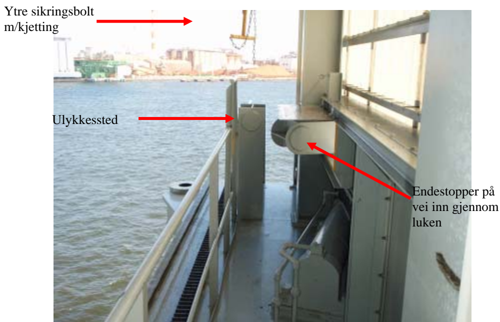
Figur 2: Ulykkessted oppe på aktre bærebjelke, styrbord side, i gantrykran nr.1.
