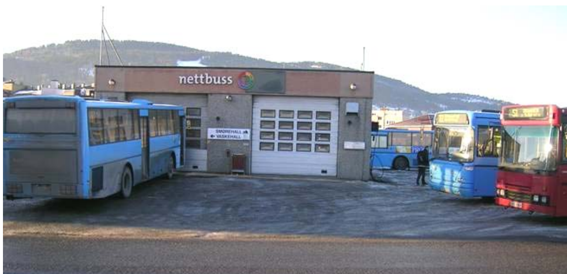
Figur 10: Bussparkering i forkant av vaske- og smørehall mot Grønland i januar 2006. Oppstillingen av busser er tilnærmet identisk som på ulykkestidspunktet.
