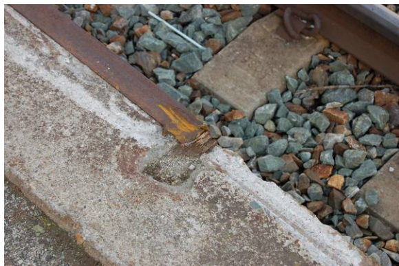
Figur 3. viser skade på plattformen.
