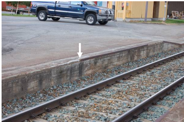
Figur 4. pilen viser hvor et av vinkeljernene var festet.
