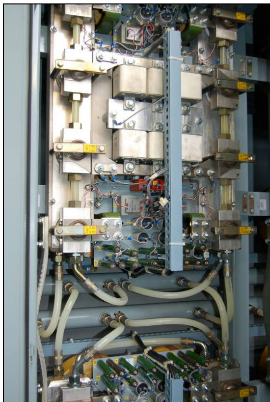
Figur 8 Modifisert løsning for plastslanger og koblinger.
