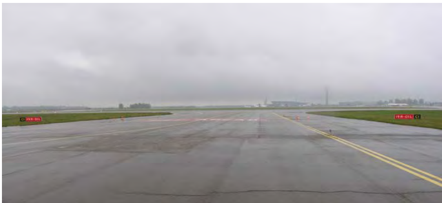
Figur 2: Venteposisjon C1 sett fra GA-området
