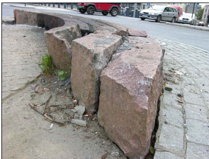
Figur 12: Steinene som minibussen traff etter kollisjonen med trikken. Høyden på sidehindret ble her målt til 36 cm.
