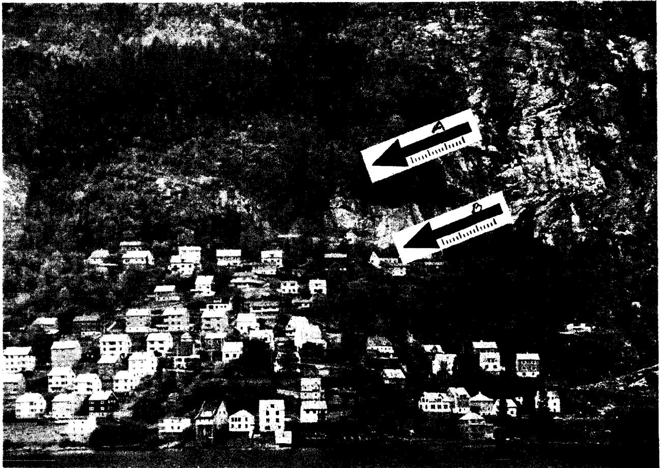
.A: Stedet for motorkutt B: Nr 22 i Øvre Kalvanesvegen
