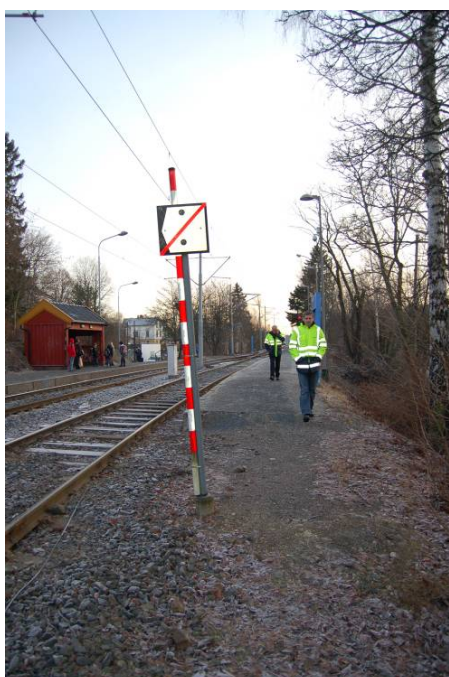
Figur 10 og 11: Skilt (siktmerke og feltstolpe) stod i siktlinjen til signal S 556 og trikken foran. Dette skiltet var plassert 30 meter foran signal S 556.
