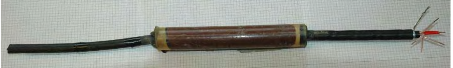
Figur 1 Oversiktsbilde av kabelmuffe mottatt for undersøkelse.
