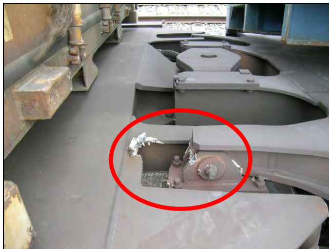
Figur 6: Viser noen av skadene som oppstod på den nest siste vognen.
