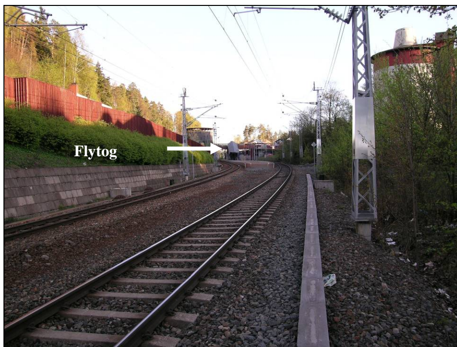
Figur 15: Siktlinjen fra lokomotivets førerhytte i retning Slependen blokkpost. Flytog 13905 hadde stoppet og befant seg bak overbygget på Slependen holdeplass.
