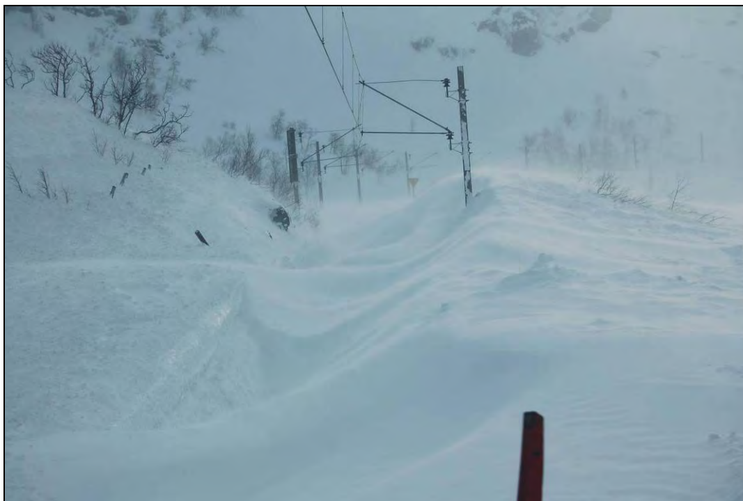
Figur 16: Snømengden i sporet var opp mot 4 meter etter at banen har vært stengt over natten.
