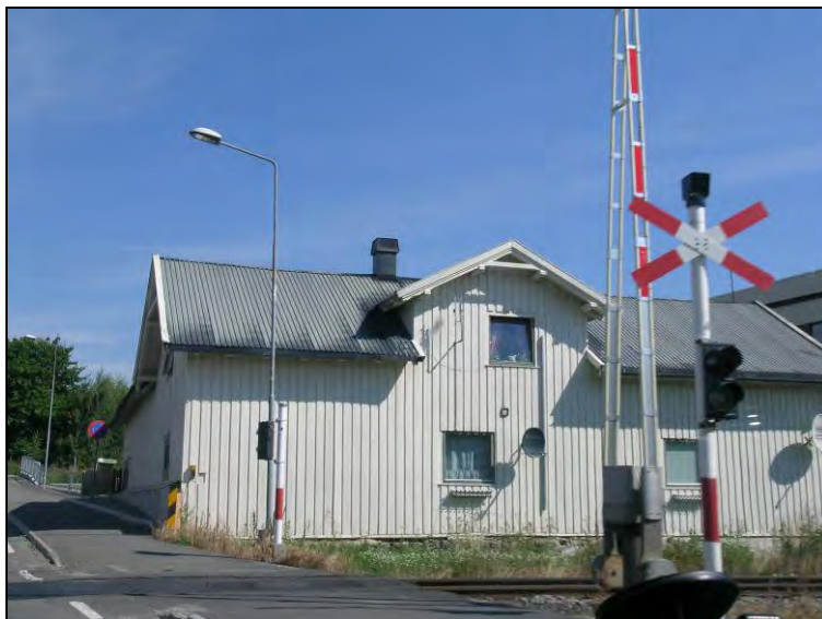
Figur 48: Ekstra signallys (rødt) på toppen av andreakors.
