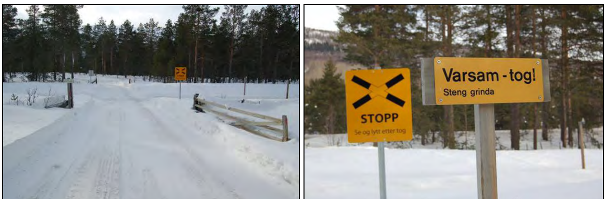
Figur 10: Eksempel på grinder og skilting (privat planovergang på Raumabanen).
