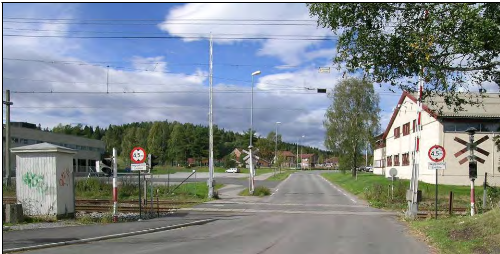
Figur 6: Eksempel på helbom og bra skiltet veisikringsanlegg (Spydeberg).
