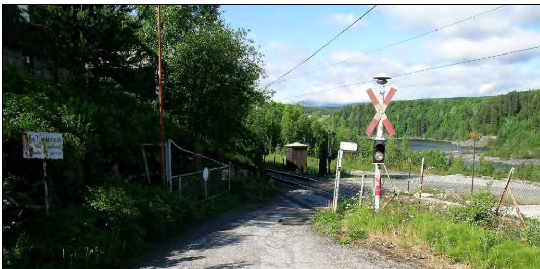
Figur 8: Eksempel på lyd og lyssignaler (Embretsfoss Plo. før ombygging til helbomanlegg).
