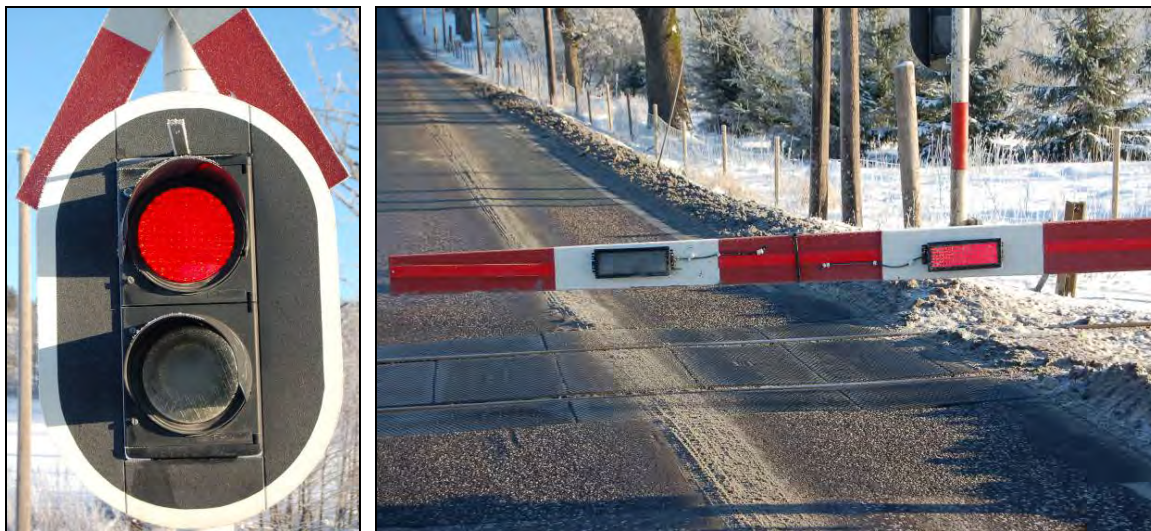
Figur 47: Skjerm som fremhever signalet og pendlende varselslys på bom.
