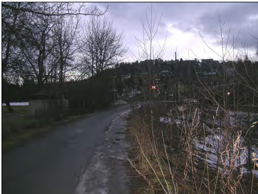
Figur 53: Vegetasjon hindrer sikt mot Planovergang (Stavne).
