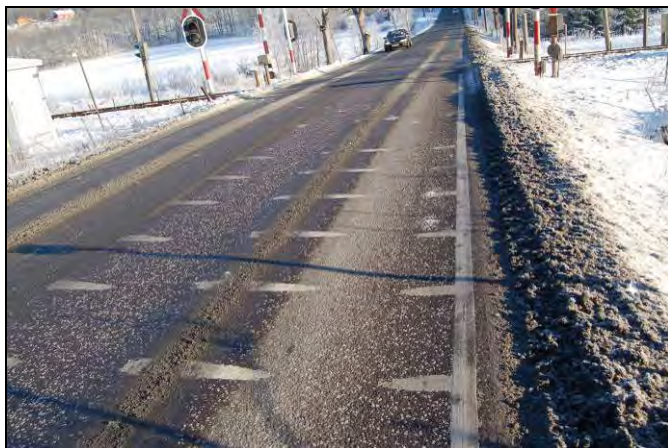
Figur 50: Et eksempel på et dårlig vedlikeholdt rumlefelt (Tomsbakken).
