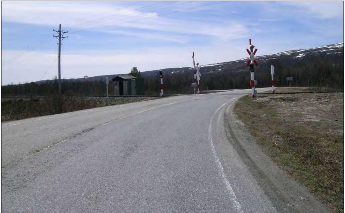
Figur 42: Befaring på Harborg Plo., Rørosbanen.
