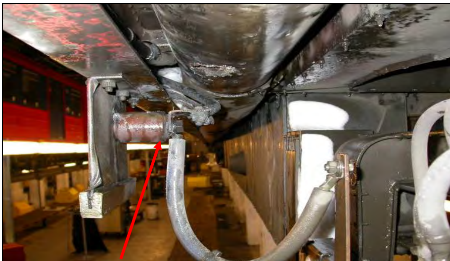
Figur 17: Bilde av kabel og isolator ved strøminntak.
