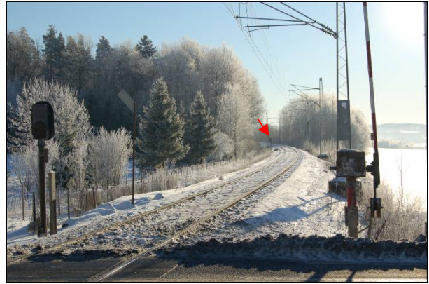
Figur 3: Sett fra planovergangen mot retningen toget kom fra. Forsignal WB sees til venstre i kurven.
