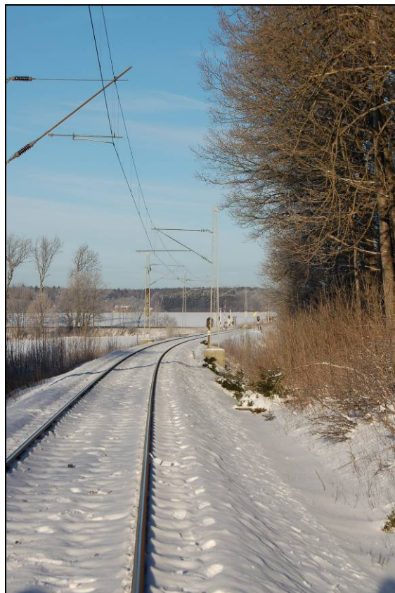
Figur 5: Forsignal WB skjermes av en KL-mast.
