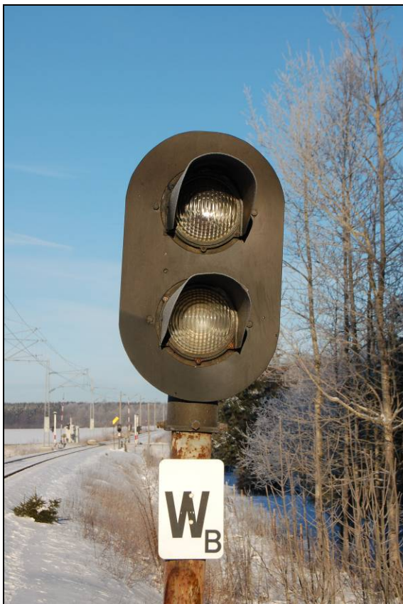
Figur 4: Forsignal WB, planovergangen sees i bakgrunnen.
