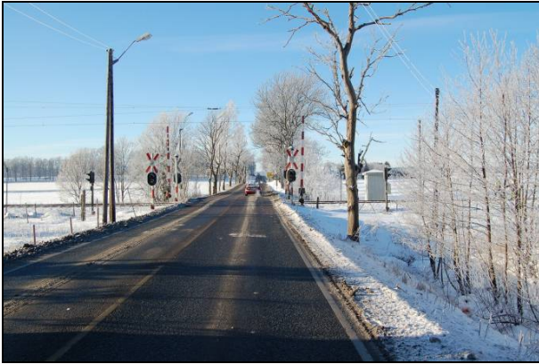
Figur 2: Planovergangen sett i retning mot vest.
